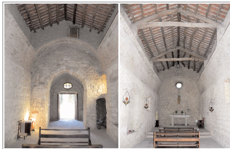
SANTA MARIA DE CAMPANYAR. Interior, vist des d'un cap i des de l'altre.
