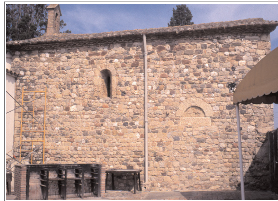
SANT LLORENÇ DE FONTCALÇADA. Façana de migdia.
