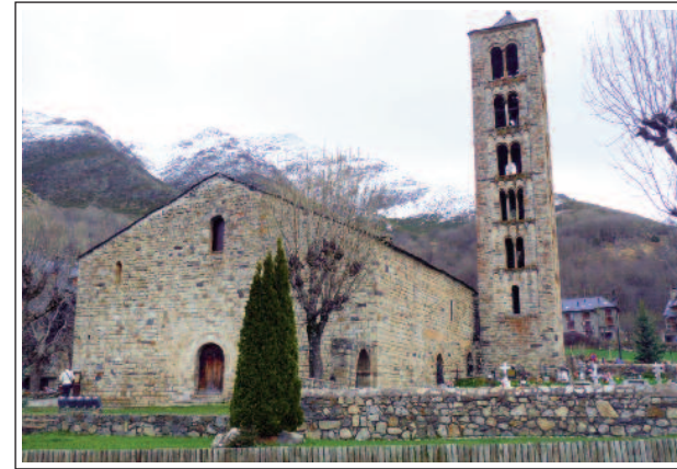
SANT CLIMENT DE TAÜLL. Façana.
