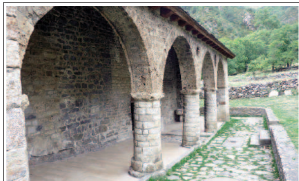
SANTA EULÀLIA D'ERILL LA VALL. Porxo que aixopluga el portal.
