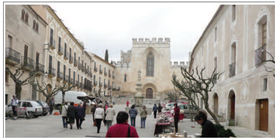
MONESTIR DE SANTES CREUS. Passeig d'entrada al recinte. Al fons l'entrada occidental de l'església.
