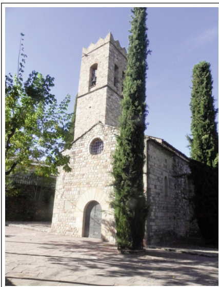
SANTA MARIA DE PALAU-SOLITÀ. Façana actual de l'església orientada al sud-est.
