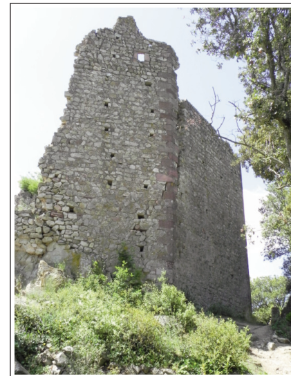
CASTELL DE MONTBUI. Façana de tramuntana.
