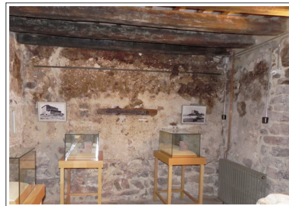
CASTELL DE PLEGAMANS. Interior de la planta baixa de la torre.
