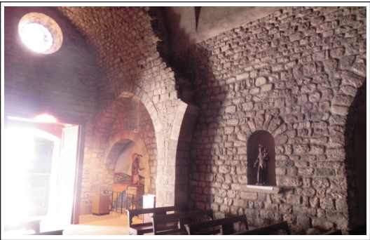
SANTA MARIA DE PALAU-SOLITÀ. Interior de la nau on podem veure el curt tram gòtic de l'entrada reforçat amb arcs formers.
