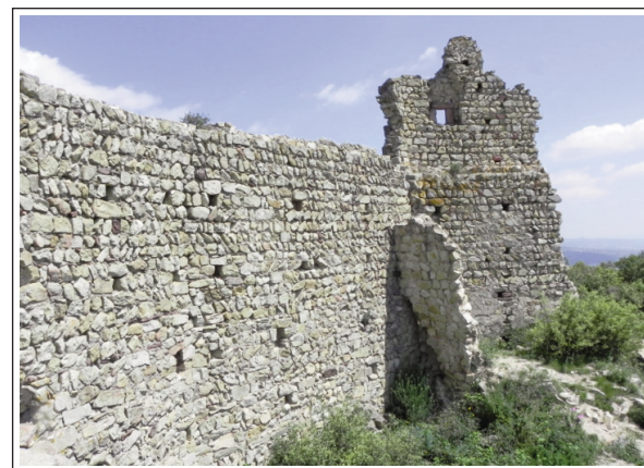
CASTELL DE MONTBUI. Cara interior de la muralla amb restes del mur que delimitava una de les sales.
