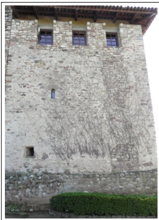
CASTELL DE PLEGAMANS. Façana a tramuntana de la torre.
