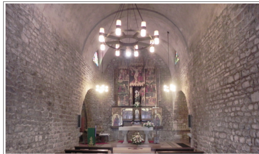
SANTA MARIA DE PALAU-SOLITÀ. Interior de la nau amb el presbiteri actual al fons.
