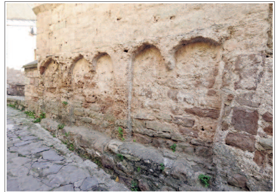
SANT MARTÍ DE MURA. Arcuacions del mur de tramuntana.
